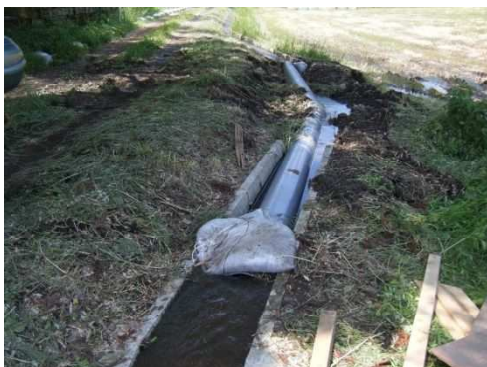
応急措置後の用水路
