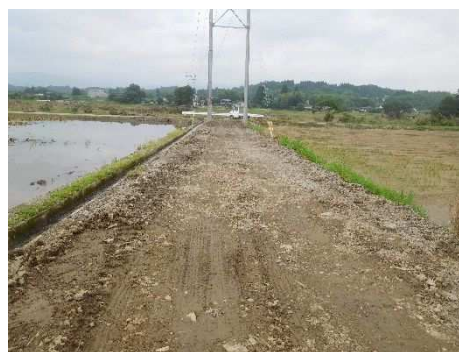
復旧後の農道状況
