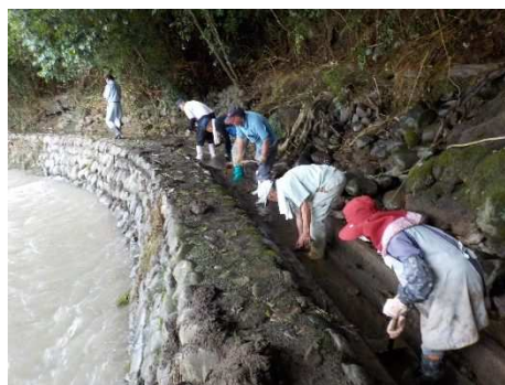
用水路の土砂撤去
