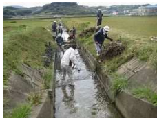
水路の泥上げ
