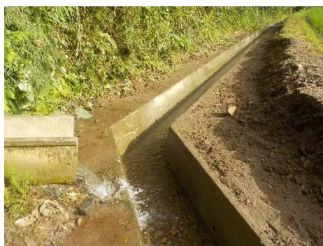
復旧後の水路状況
