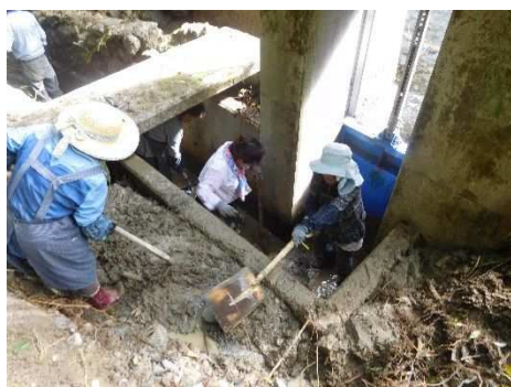
取水ゲートの土砂撤去
