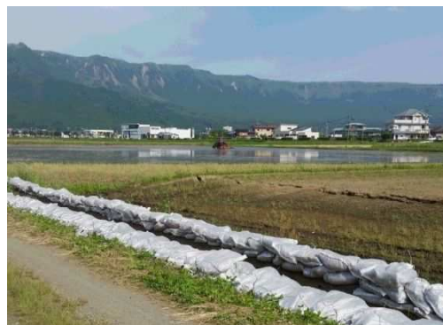
応急措置後の用水路
