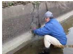
水路のひび割れ補修
