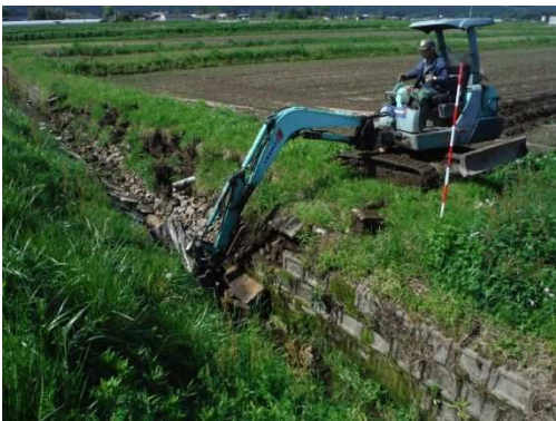
排水路側壁の復旧
