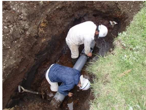
パイプラインの復旧
