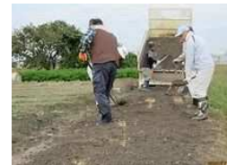
農道の窪みの補修
