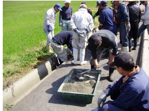
水路の目地詰め
