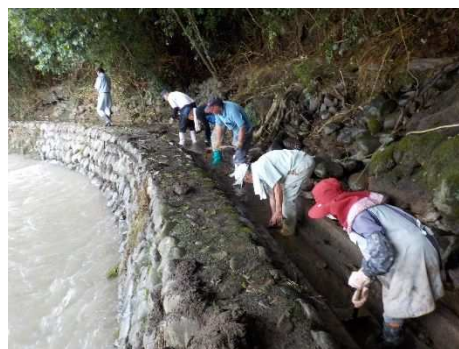
用水路の土砂撤去
