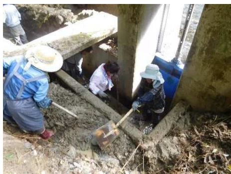
取水ゲートの土砂撤去
