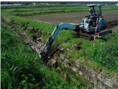
排水路側壁の復旧
