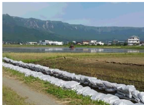
応急措置後の用水路
