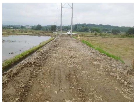
復旧後の農道状況
