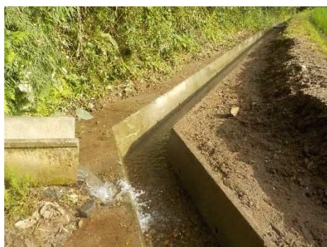
復旧後の水路状況
