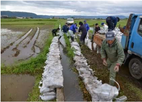
水路への土のう設置
