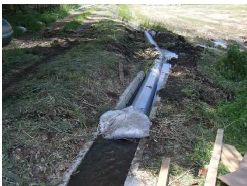
応急措置後の用水路
