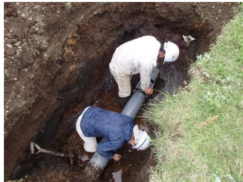
パイプラインの復旧
