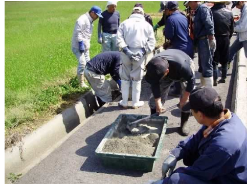
水路の目地詰め
