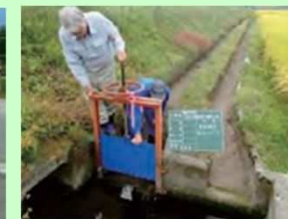
地区の管理ゲート一括補修
